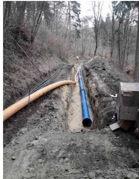
Verlegung der Rohbiogas-Leitung hin zur zentralen Aufbereitungsanlage © Stadtwerke Trier
