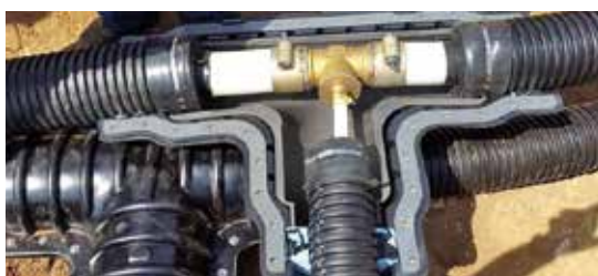
Stichleitung im Nahwärmenetz von Haßfurt-Osterfeld © Stadtwerk Haßfurt GmbH
