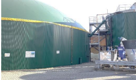
Biogasanlage HBFZ Bad Hersfeld (Bild: ASUE)
